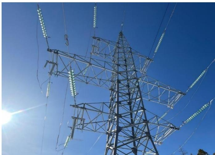
Рис. 4. Установка линейных разрядников на опоре ЛЭП класса напряжения 220 кВ
