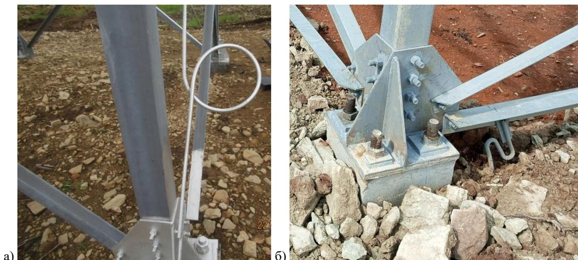
Рис. 3. Варианты форм заземлителей металлической решетчатой опоры:
