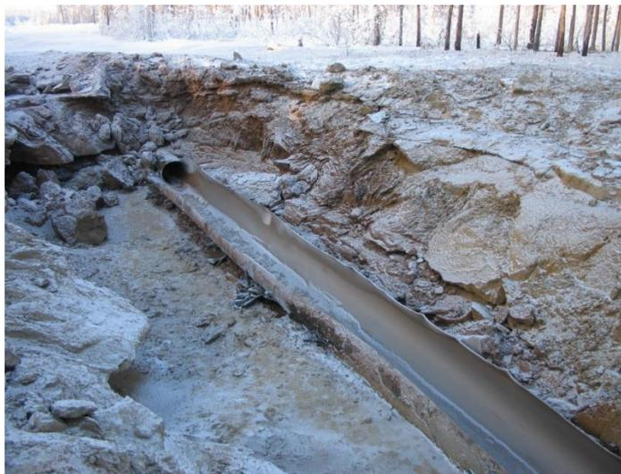
Рис. 3. Общий вид разрушения газопровода
