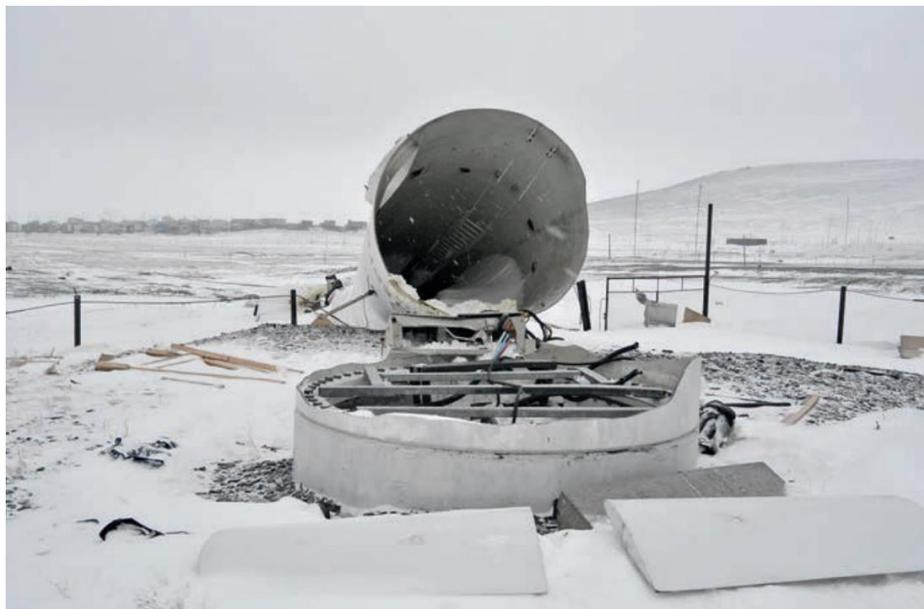
Рис. 1. Разрушенная ВЭУ TW-250 в п. Тикси [1]
