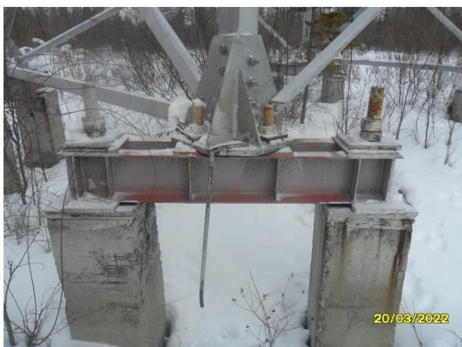
Рис. 1. Обрыв заземляющего проводника в результате выдавливания железобетонных фундаментов из грунта силами морозного пучения
